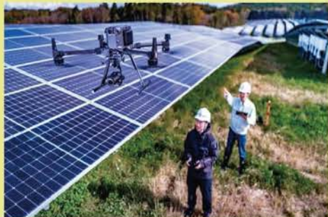
▲ドローンを使ったパネル点検
